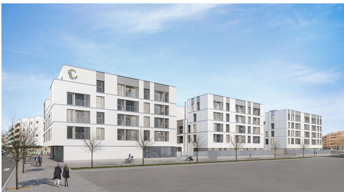
Foto de la façana posterior del projecte de 101 habitatges
